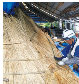
久野邸茅葺屋根葺き替え工事
