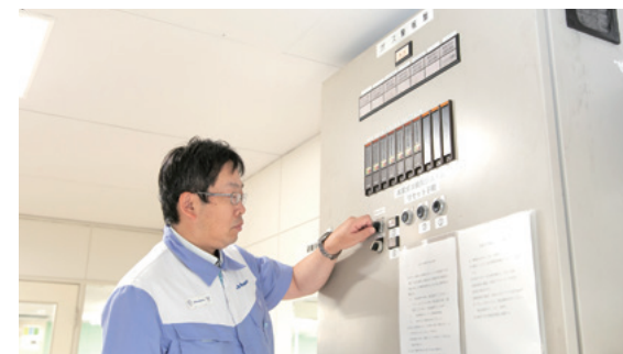
水素ガス漏れ検知器点検
