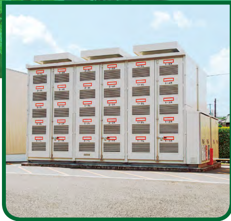
NAS電池：電力使用を平準化する為、夜間電気を貯めて昼間放電します
