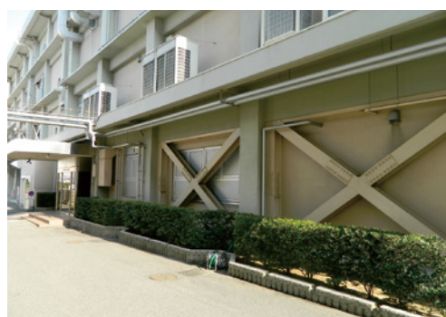
ブレースによる耐震補強を、古い基準の建物に行いました。
