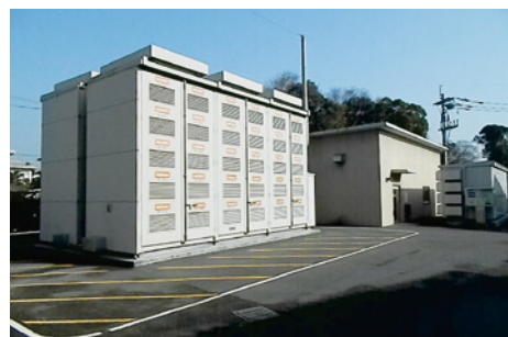
NAS電池を稼働させ、電気使用量の平準化を行っています。
