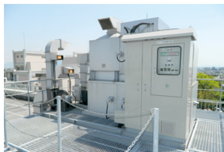
排気燃焼装置を稼働させ、トルエンが直接大気に排出しないようにしています。
